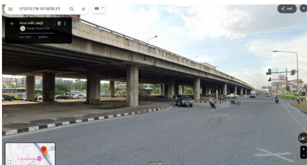
รูปที่ 2 สะพานข้ามแยกบายพาสพนัสนิคม ทล.361
